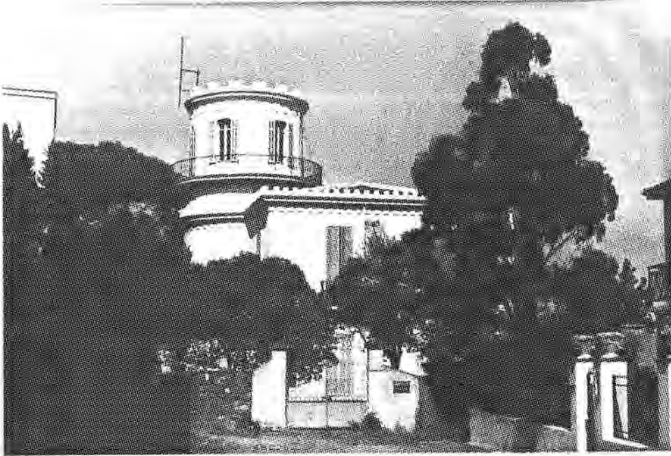
CLARISSE 1880 (?) façade Est
