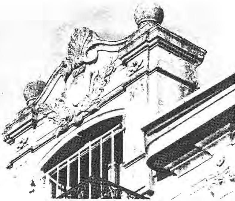
détail de la fenêtre de l'atelier à l'Ouest
