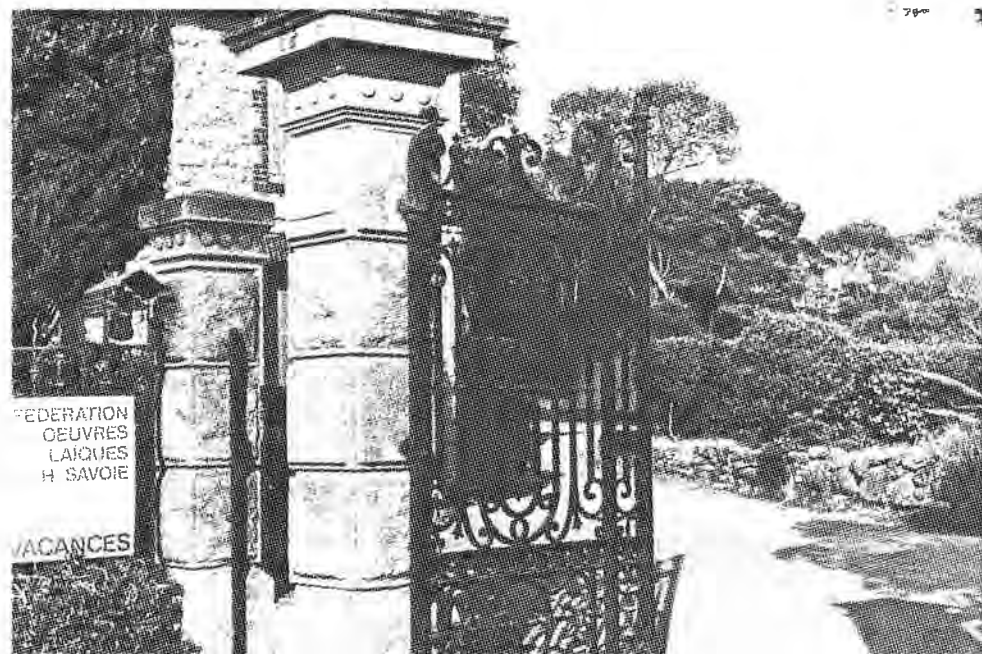
"Les Colombes Grises" appareil en moellons de la conciergerie
