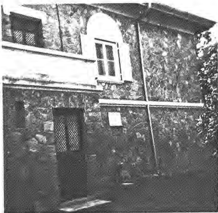
façade Nord détail
